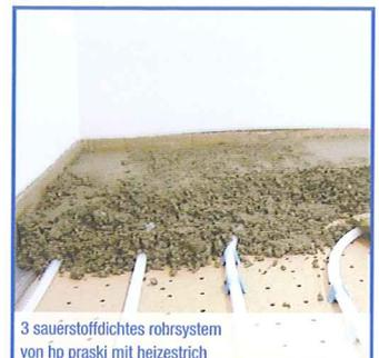
3 sauerstoffdichtes rohrsystem von hp praski mit heizestrich
