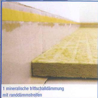
1 mineralische trittschalldämmung mit randdämmstreifen
